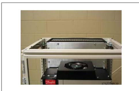
Abbildung 3.48: Montierte Abschlussplatte
