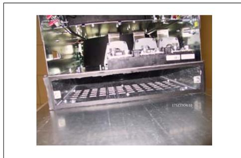
Abbildung 3.33: Montierter Bodenadapter
