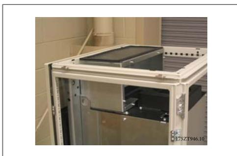
Abbildung 3.46: Montierte obere Lüftungsbaugruppe
