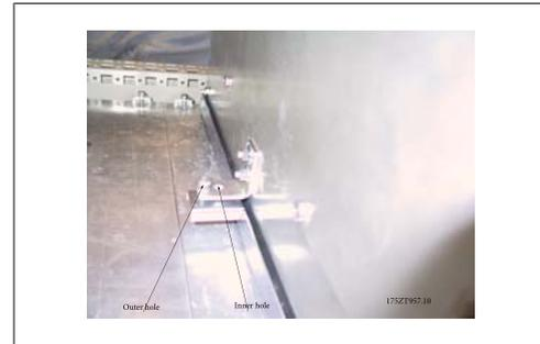
Abbildung 3.58: Befestigungsschrauben von äußerer zu innerer Bohrung versetzen
