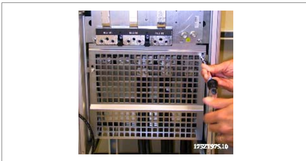
Illustration 3.81: Montage du blindage CEM
