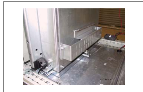
Ilustración 3.59: Conducción inferior instalada.
