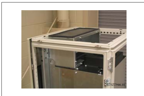
Ilustración 3.46: Conducción superior instalada
