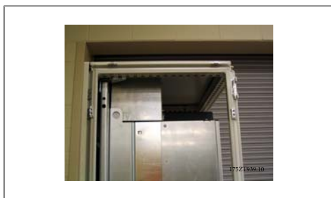
Ilustración 3.38: Sistema de ventilación superior y parte superior del armario instalados
