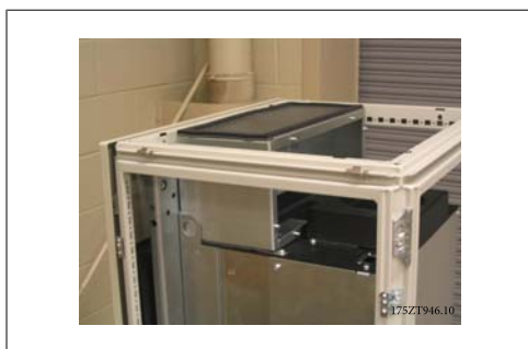
Afbeelding 3.46: Bovenste luchtkanaal geïnstalleerd
