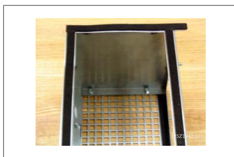
Afbeelding 3.43: Pakking aangebracht aan weerszijden van de beugel van de frequentieomvormer en de bovenafdekking van het luchtkanaal met ventilatierooster.
