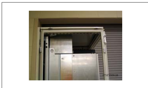
Afbeelding 3.38: Bovenste luchtkanaal en bovenafdekking kast geïnstalleerd
