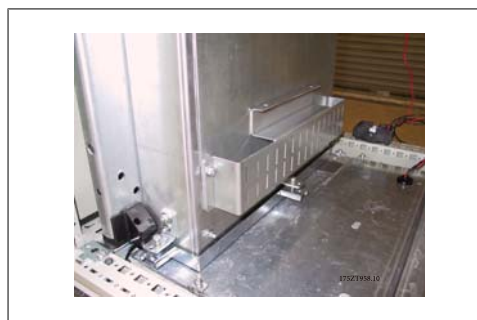
Afbeelding 3.59: Onderste luchtkanaal geïnstalleerd.
