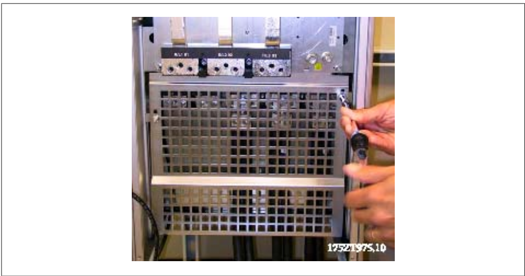
Ilustração 3.81: Montagem da proteção de EMC
