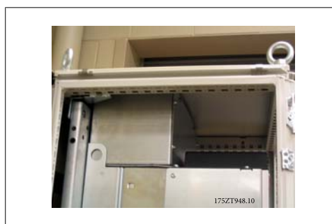
Ilustração 3.49: Parte de cima do gabinete metálico instalada
