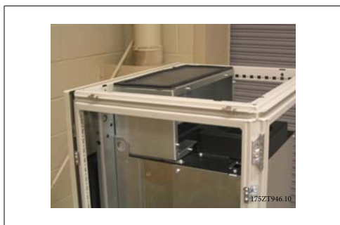
Ilustração 3.46: Duto superior instalado
