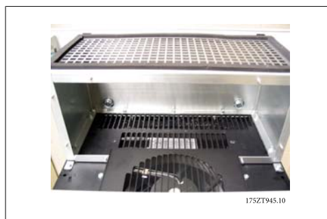
Ilustração 3.42: Duto superior instalado
