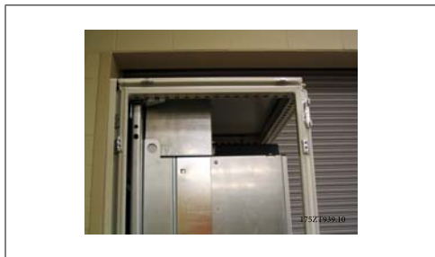
Ilustração 3.38: Tubulação superior e topo do gabinete metálico instalado
