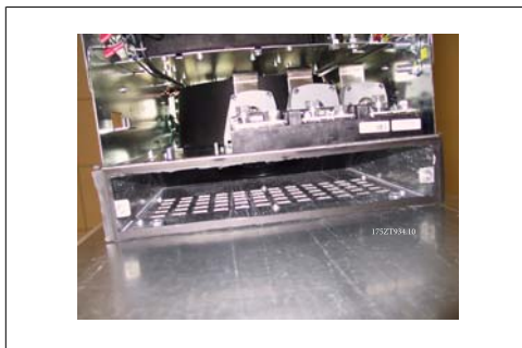
Ilustração 3.33: Adaptador do duto inferior instalado
