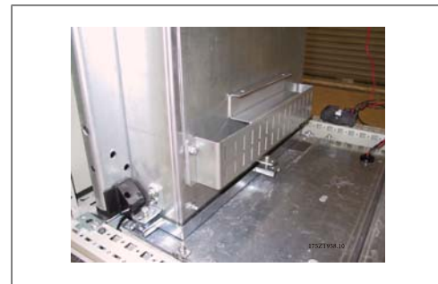
Ilustração 3.59: Duto inferior instalado.
