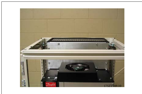
图 3.48: 安装好的顶部风道盖板
