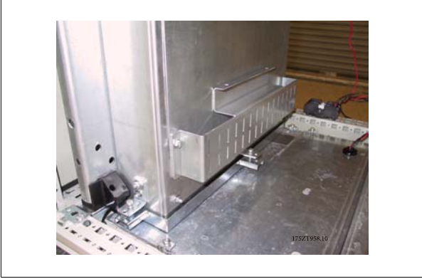
图 3.59: 安装好的底部风道。
