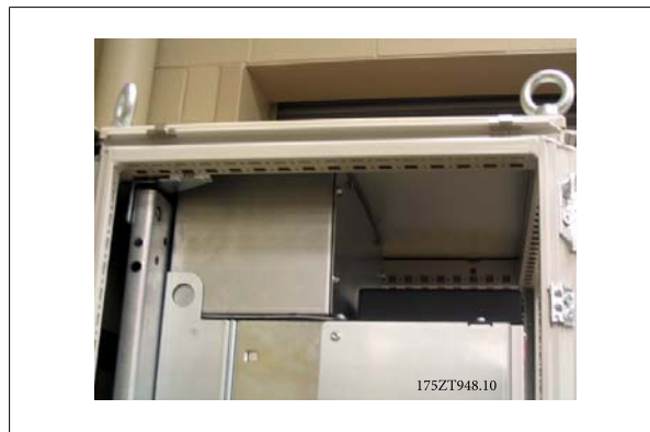
图 3.49: 安装好的机箱顶板
