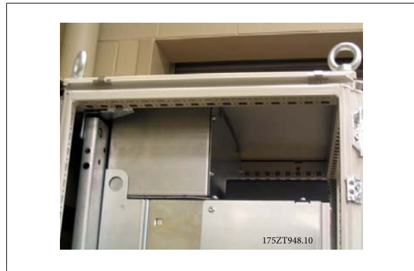
圖 3.49: 安裝完成的外殼上部
