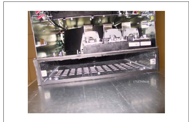
圖 3.33: 已安裝的底部導管配合件
