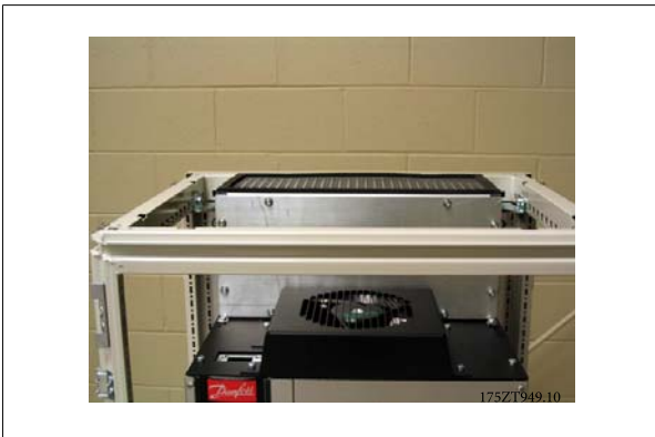
圖 3.48: 安裝完成的上方導管關閉板
