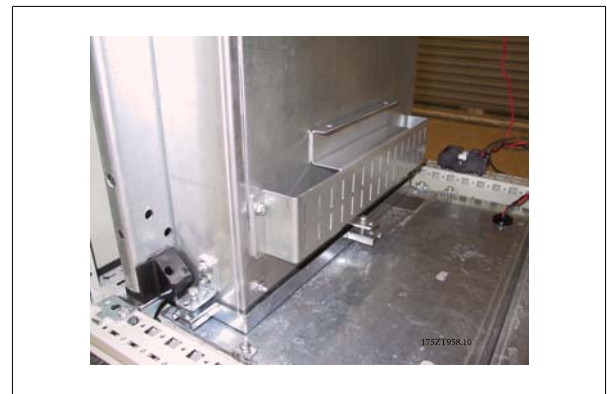
圖 3.59: 已安裝的底部導管。
