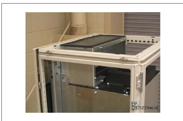
圖 3.46: 安裝完成的上方導管
