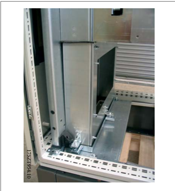
圖 3.54: 暫時安裝導管工件以標示纜線固定頭上的切口
