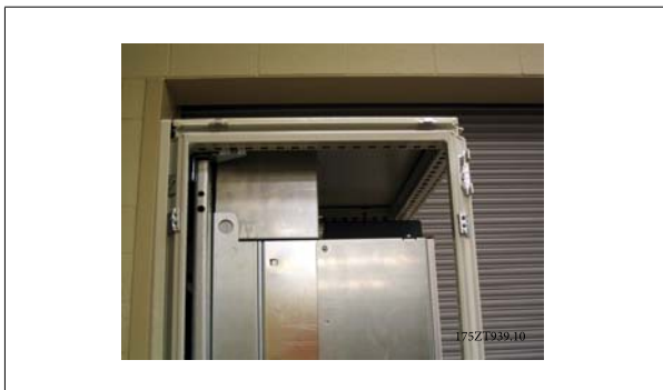
圖 3.38: 已安裝的上方管路工件與外殼頂部
