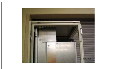
Рисунок 3.38: Верхний воздухопровод и установленный верх корпуса
