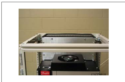
Рисунок 3.48: Установленная закрывающая пластина верхнего воздуховода
