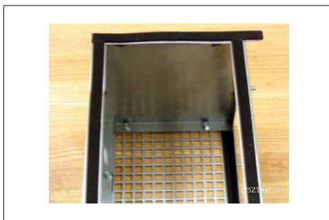
Рисунок 3.43: Прокладка прилегает к обеим сторонам кронштейна преобразователя частоты и вентиляционной верхней крышки воздуховода.
