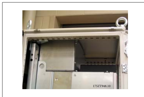
Рисунок 3.49: Установленный верх корпуса
