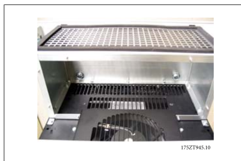
Рисунок 3.42: Установленный верхний воздуховод
