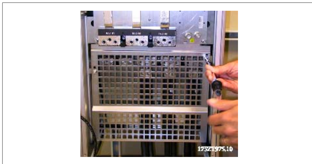
Рисунок 3.81: Монтаж экрана ЭМС
