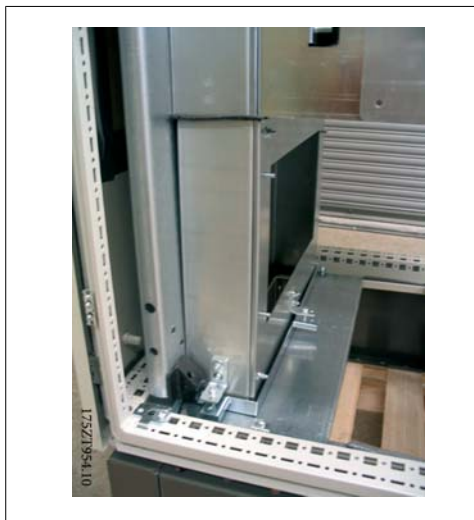
Рисунок 3.54: Временно установите воздуховод, чтобы произвести разметку выреза на уплотнении
