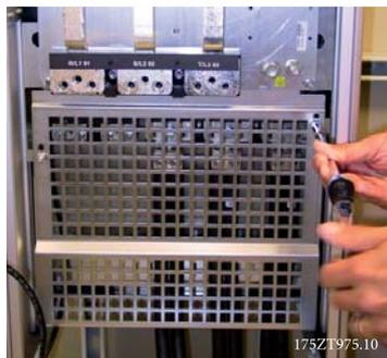
Disegno 4.15: Montaggio della schermatura EMC.
