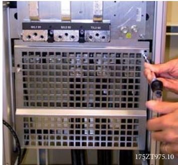
그림 4.15: EMC 차폐용 금속 덮개 장착.
