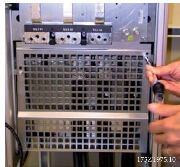
图 4.15: EMC 防护罩的安装。
