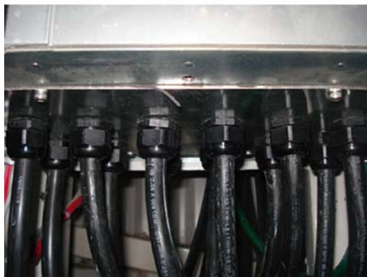
Illustration 4.24: Eksempel på korrekt installation af tætningspladen.
