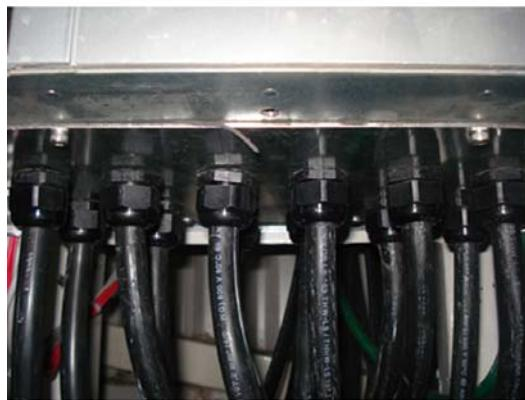
그림 4.24: 글랜드 플레이트의 올바른 설치 예
