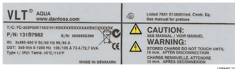
Ilustración 3.1: Etiqueta de identificación de ejemplo para VLT AQUA Drive.
