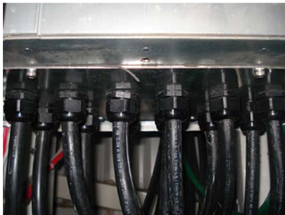
Illustration 5.11: Eksempel på korrekt installation af tætningspladen.
