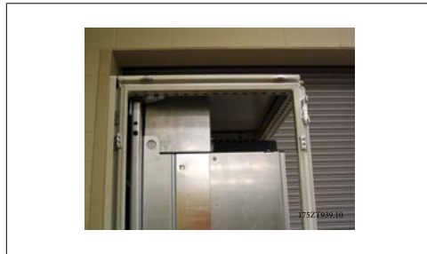
Abbildung 3.38: Montierte obere Lüftung und Schaltschrank-Dachblech
