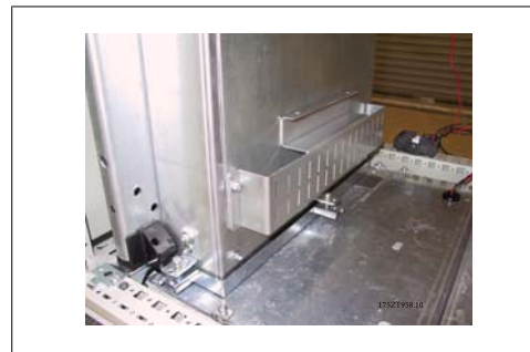
Abbildung 3.59: Montierte Bodenbaugruppe
