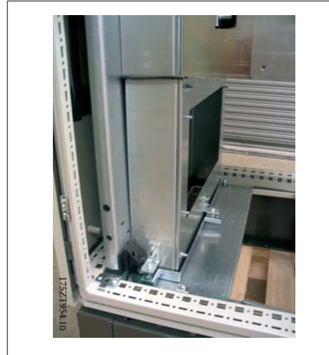
Illustration 3.54: Installer temporairement la gaine pour marquer la découpe sur le presse-étoupe.
