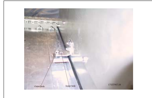
Illustration 3.58: Déplacer les vis de montage du trou extérieur vers le trou intérieur.
