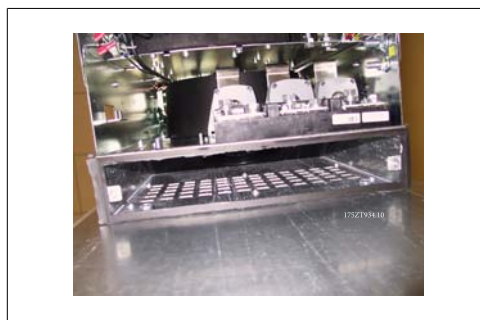
Afbeelding 3.33: Passtuk onderste luchtkanaal geïnstalleerd
