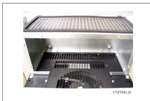
Afbeelding 3.42: Bovenste luchtkanaal geïnstalleerd
