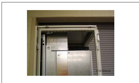
Afbeelding 3.38: Bovenste luchtkanaal en bovenafdekking kast geïnstalleerd
