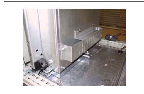
그림 3.59: 설치된 하단 덕트.
