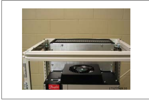
그림 3.48: 상단 덕트 마감 플레이트 설치된 모습
