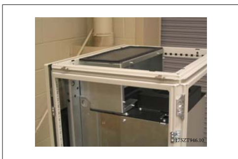
그림 3.46: 상단 덕트 설치된 모습
