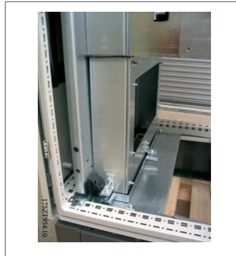
그림 3.54: 절단선을 표시하기 위해 덕트를 글랜드에 임시로 설치하십시오.
