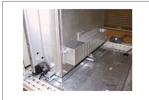
图 3.59: 安装好的底部风道。
