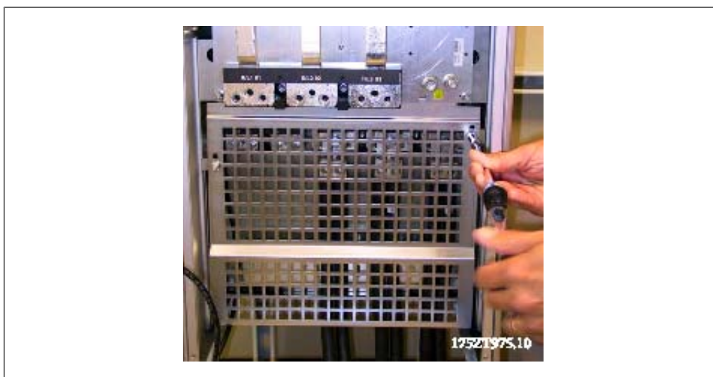
图 3.81: EMC 防护罩的安装。
