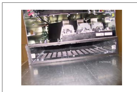
图 3.33: 安装好的底部风道接头
