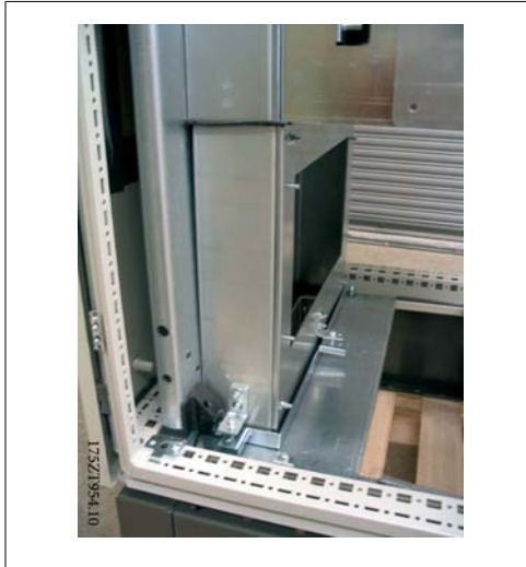
图 3.54: 暂时安装的风道系统（用于在密封板上做开口标记）。
