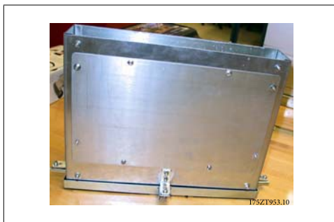
图 3.53: 完全装配的底部风道系统
