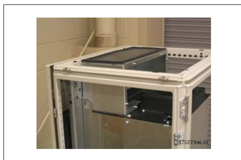
Рисунок 3.46: Установленный верхний воздуховод
