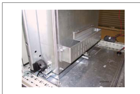
Рисунок 3.59: Установленный нижний воздуховод.
