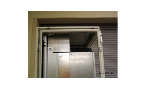
Рисунок 3.38: Верхний воздуховод и установленный верх корпуса
