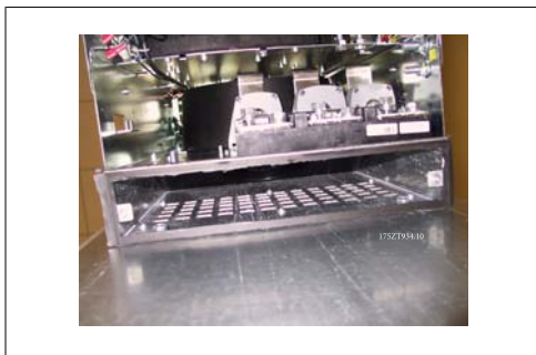
Рисунок 3.33: Установленный переходник нижнего воздуховода
