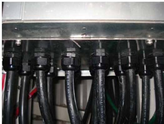
Afbeelding 3.25: Voorbeeld van juiste installatie van de doorvoerplaat.
