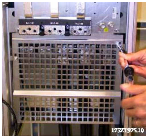
Ilustración 6.48: Instalación del apantallamiento EMC.
