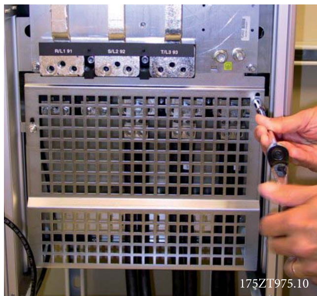
Illustration 8.32: Montering af EMC-skærmen.
