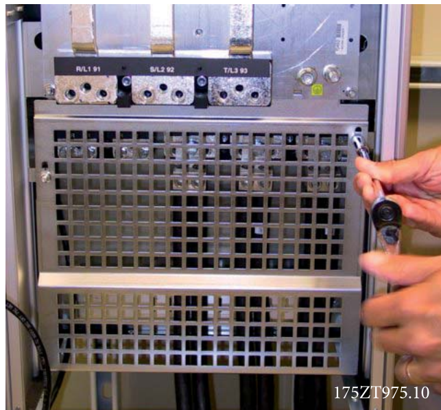
Disegno 8.32: Montaggio della schermatura EMC.
