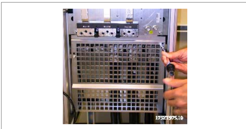
Illustration 3.81: Montering af EMC-skærmen.
