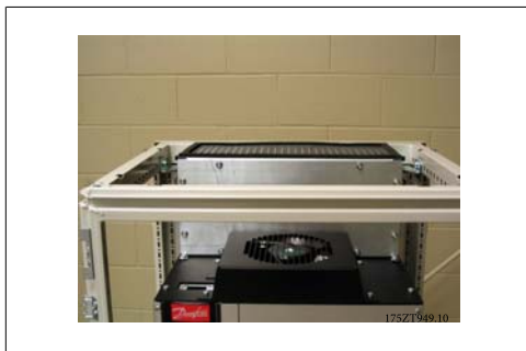
Illustration 3.48: Plaque de fermeture de la gaine supérieure installée
