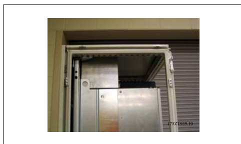
Illustration 3.38: Gaine supérieure et haut de la protection installés
