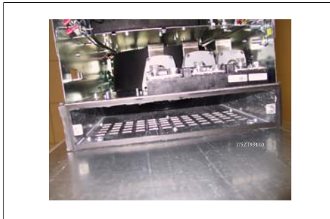
Illustration 3.33: Adaptateur de gaine inférieure installé
