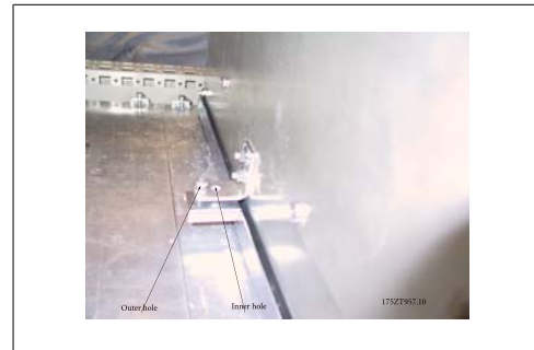
Ilustración 3.58: Pase los tornillos de montaje del agujero exterior al agujero interior
