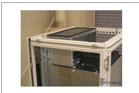
Bild 3.46: Övre kanal installerad
