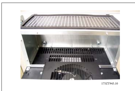
Bild 3.42: Övre kanal installerad
