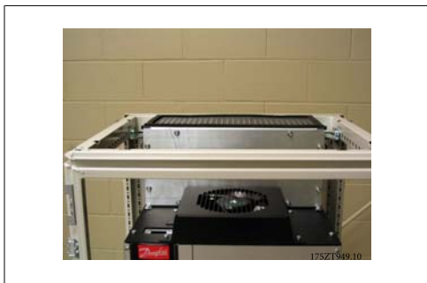
Bild 3.48: Den övre kanalens låsplatta monterad
