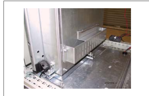
Bild 3.59: Nedre kanal monterad.
