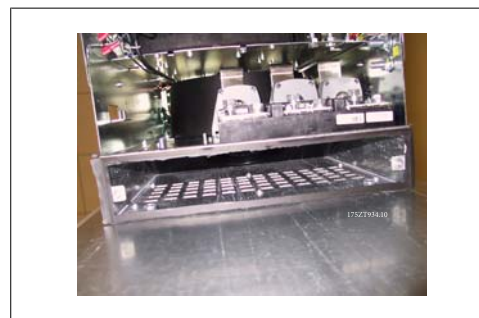
Bild 3.33: Nedre kanaladapter monterad
