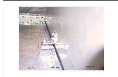
Bild 3.58: Flytta monteringskruvarna från det yttre hålet till det inre
