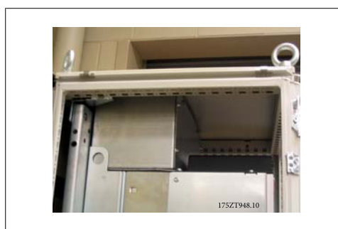
Afbeelding 3.49: Bovenafdekking van kast geïnstalleerd
