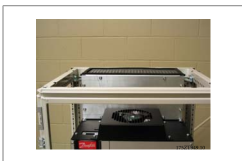
Afbeelding 3.48: Sluitplaat van bovenste luchtkanaal geïnstalleerd
