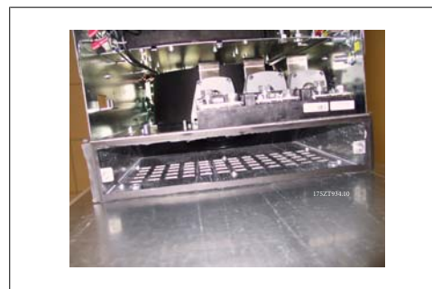
Afbeelding 3.33: Passtuk onderste luchtkanaal geïnstalleerd
