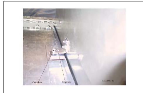
Afbeelding 3.58: Verplaats de bevestigingsschroeven van de buitenste naar de binnenste gaten
