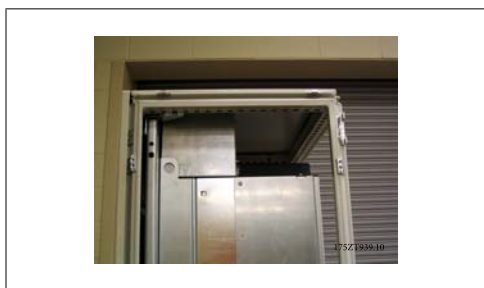
Afbeelding 3.38: Bovenste luchtkanaal en bovenafdekking kast geïnstalleerd
