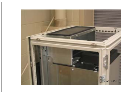
Afbeelding 3.46: Bovenste luchtkanaal geïnstalleerd
