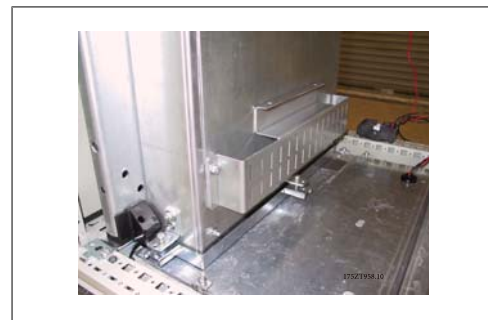
Afbeelding 3.59: Onderste luchtkanaal geïnstalleerd.
