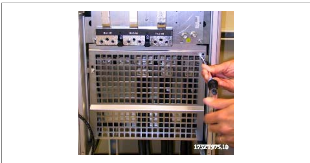
그림 3.81: EMC 차폐용 금속 덮개 장착.
