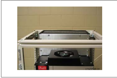
그림 3.48: 상단 덕트 마감 플레이트 설치된 모습
