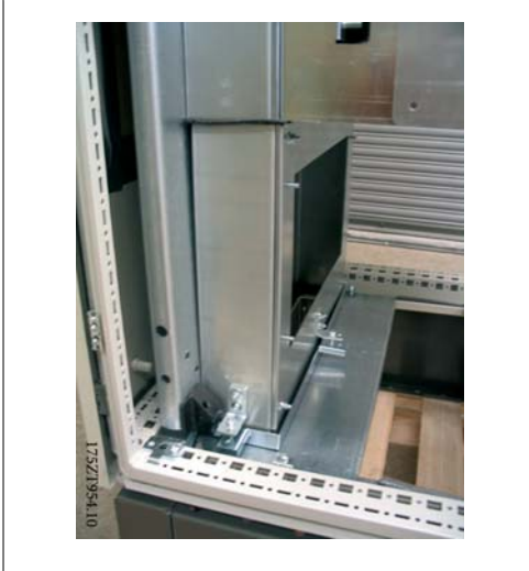
그림 3.54: 절단선을 표시하기 위해 덕트를 글랜드에 임시로 설치하십시오.
