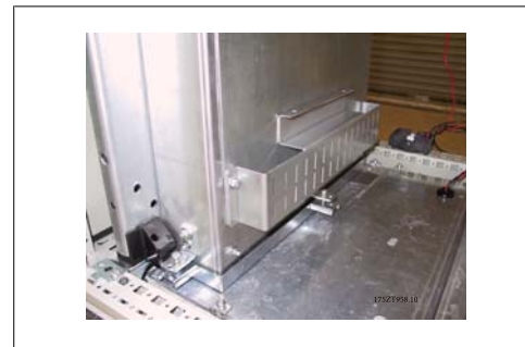
图 3.59：安装好的底部风道。
