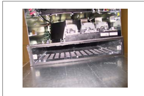
图 3.33：安装好的底部风道接头
