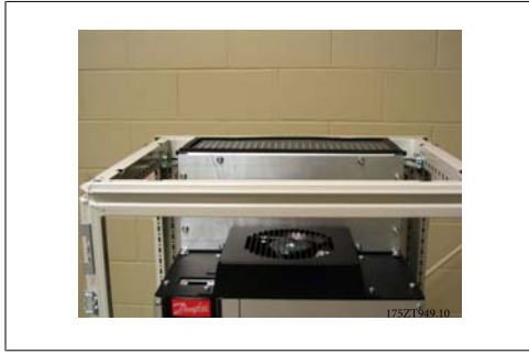
图 3.48: 安装好的顶部风道盖板
