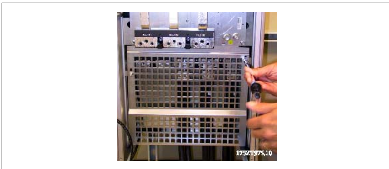
Ilustración 3.47: Instalación del apantallamiento EMC.
