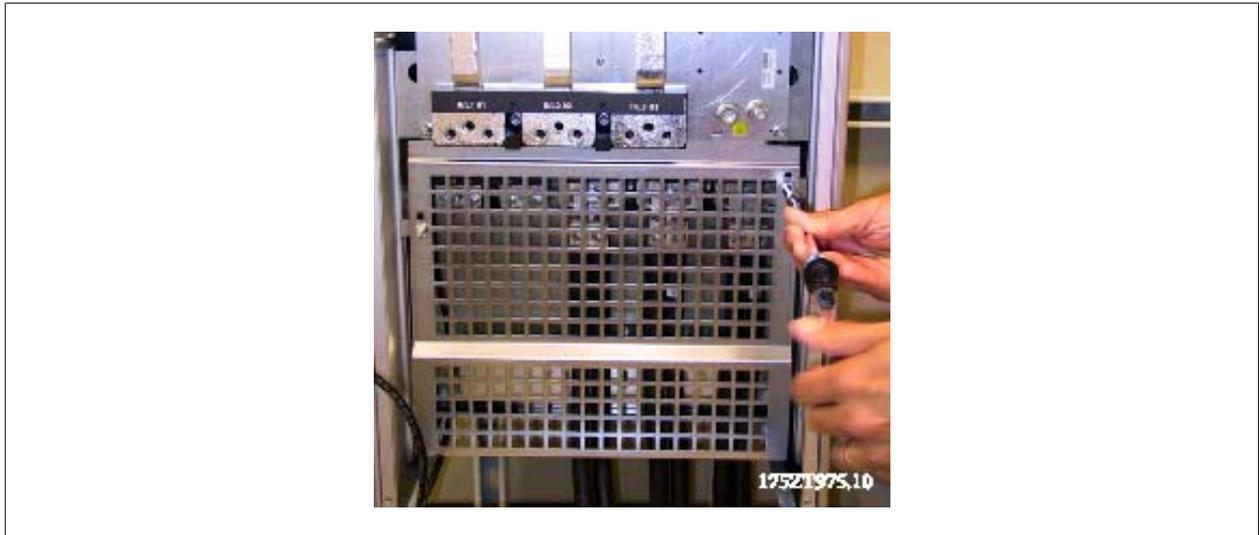
그림 3.47: EMC 차폐용 금속 덮개 장착.
