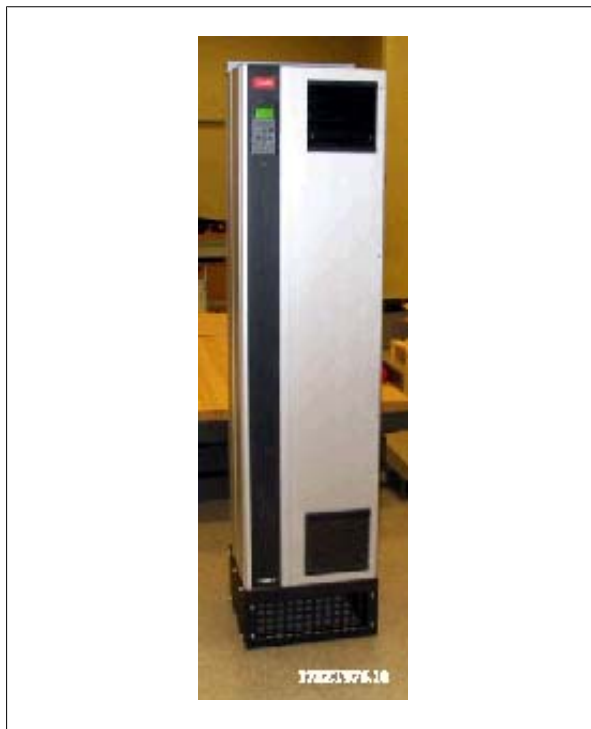
图 3.28: 安装在底座上的变频器
